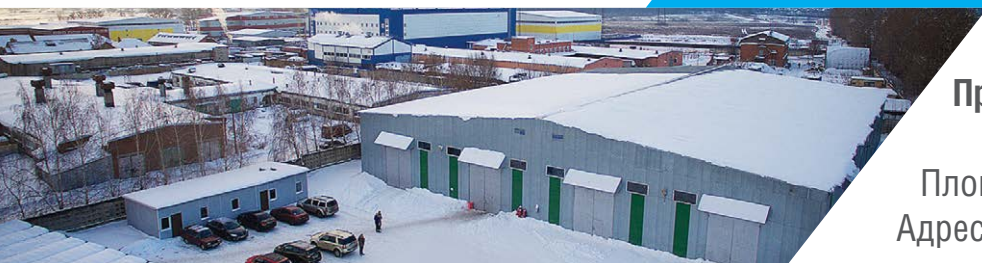
Производственная площадка в Ленинском р-не, Московская обл.
