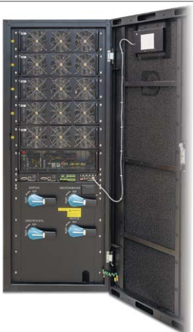
Кабинеты 150-1000 кВА на 50 кВт модулях
