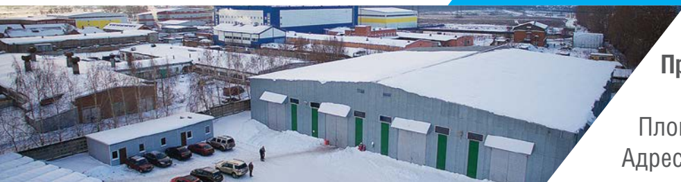
Производственная площадка в Ленинском р-не, Московская обл.
